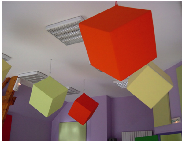
Abbildung 3.1: Schallabsorbierende Wandelemente und Raumelemente in Würfelform (Foto: raumAKUSTIKS)
