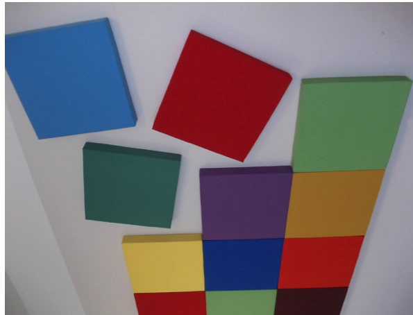
Abbildung 3.3: Vier schallabsorbierende Deckenelemente in quadratischer Anordnung (Foto: raumAKUSTIKS)
