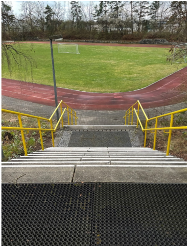
Abbildung 2.9: genormte Handläufe und markierte Treppe (Foto: bbs nürnberg)
