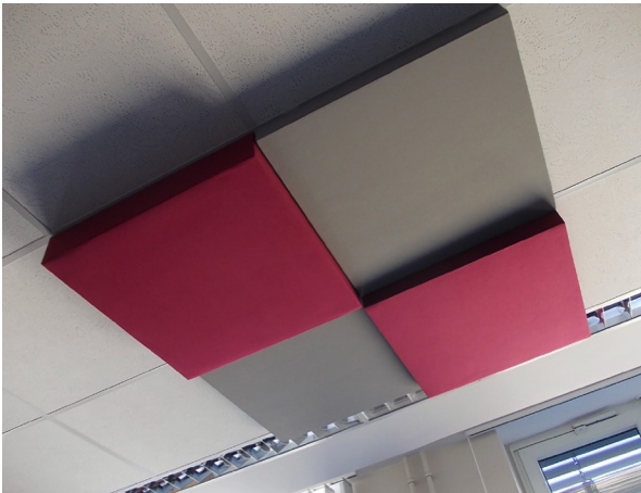
Abbildung 3.3: Vier schallabsorbierende Deckenelemente in quadratischer Anordnung (Foto: raumAKUSTIKS)
